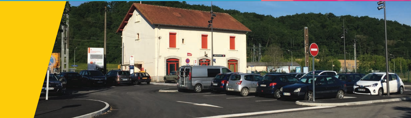
Réfection du parking SNCF
