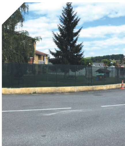
Réfection complète de la clôture de la gendarmerie
