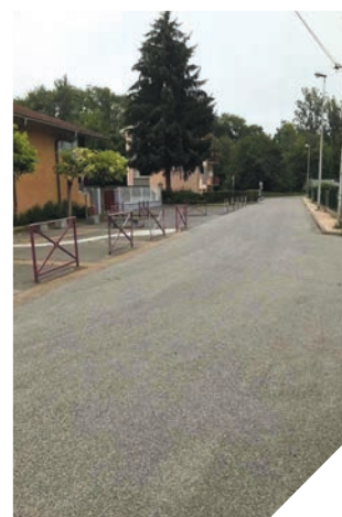
Voirie : rénovation devant le collège
