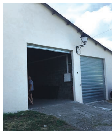
Nouveaux ateliers communaux impasse de la gare
