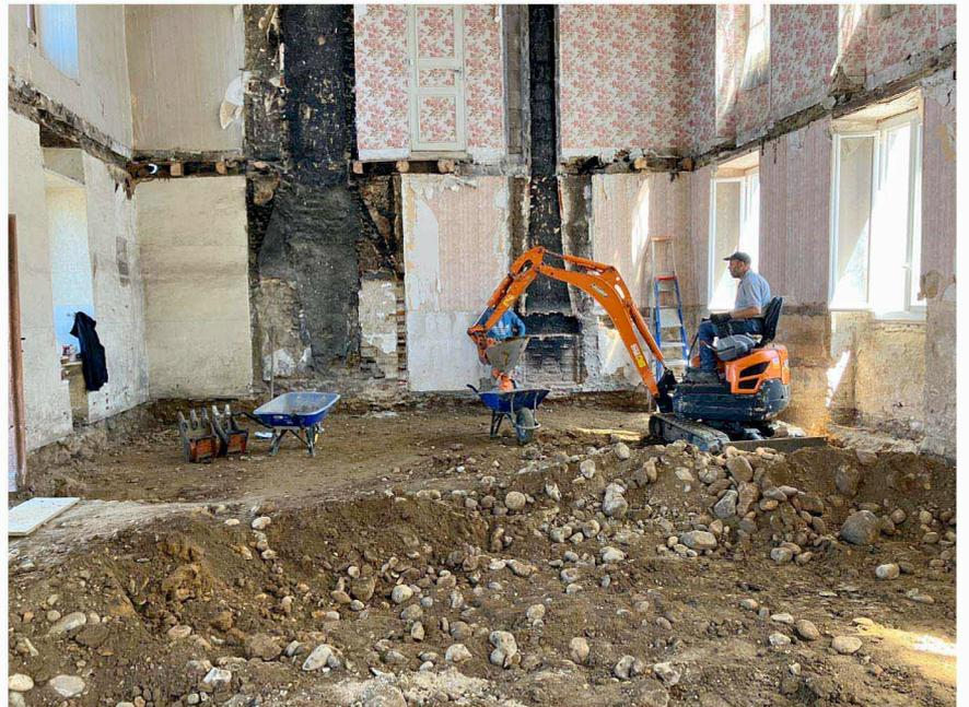
Photos du chantier vide de l'intérieur, par une technique de maintien de la structure afin de conserver la façade
