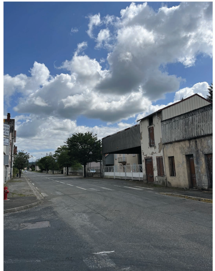
Route départementale RD817
